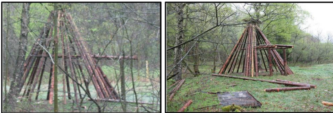
Rohbau mit inneren Abstützungen Köté mit Zwischenboden, Vorbau und Haube
